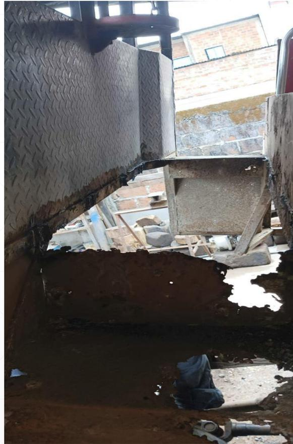
**Imagen 4.-** La parte posterior del tanque presentaba oxidación y en toda la parte inferior.
